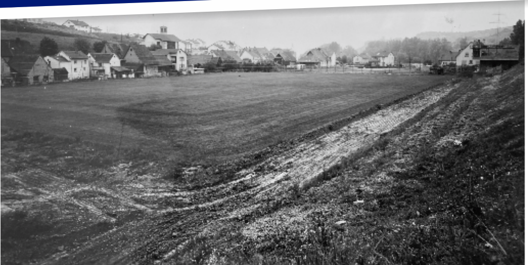
Der heutige Sportplatz ca. 1972, das Clubhaus noch im Rohbau, die 100m-Bahn ist schon zu erahnen
